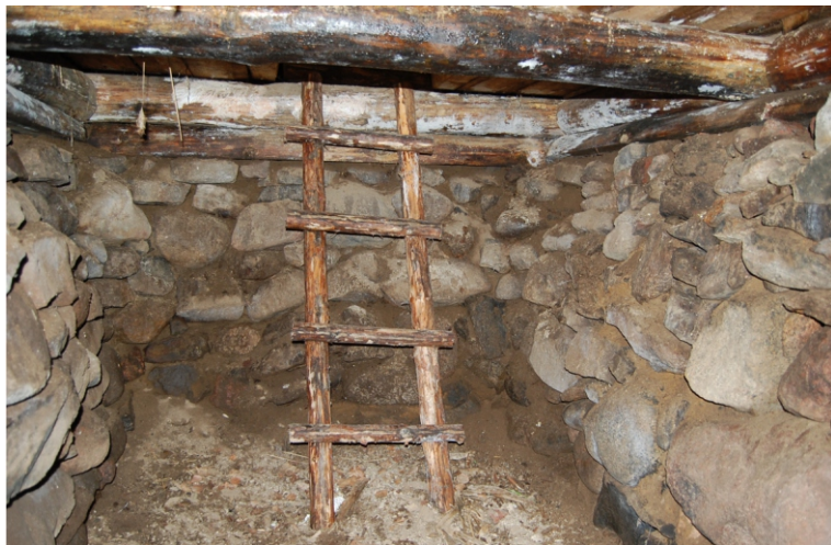
Perunakuoppa kunnostettiin vuonna 2010.
