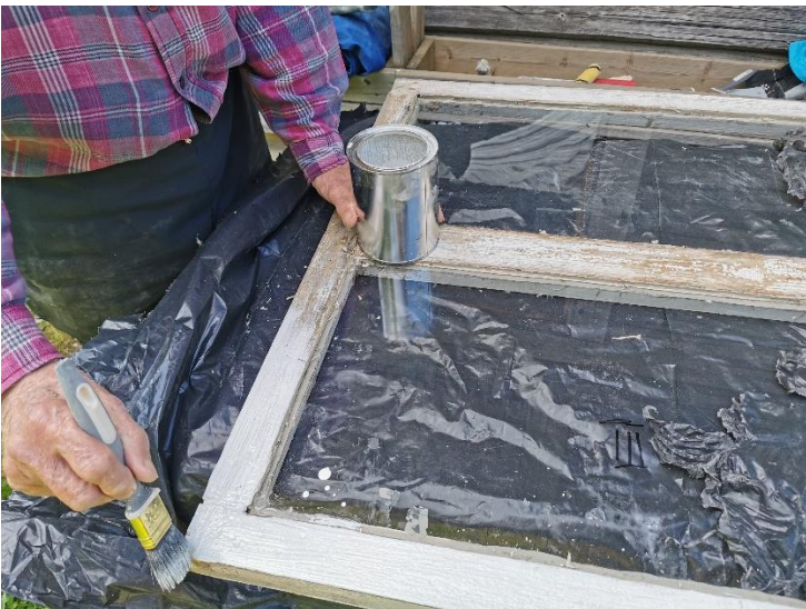
4. Hiotun ikkunapokan maalaamista pohjamaalilla
