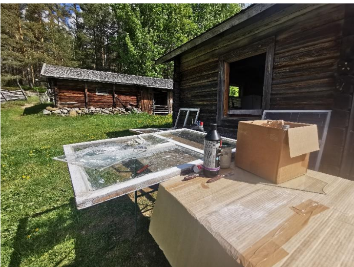
5 . Lasin kiinnityskittaus vaiheessa
